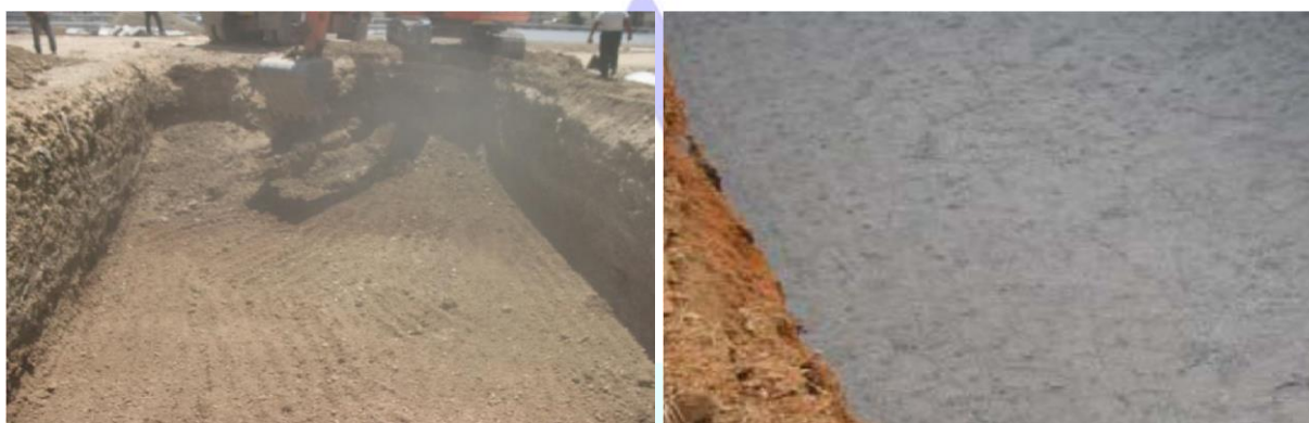
شکل ۱ نمونه هایی از آماده سازی کف چاله
