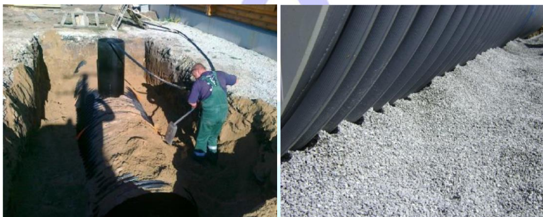
شکل ۴ نمونه ای از پر کردن اطراف پکیج
